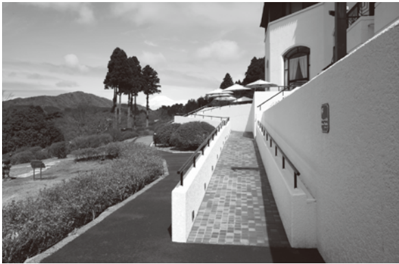
館内から庭園に出られるスロープ
